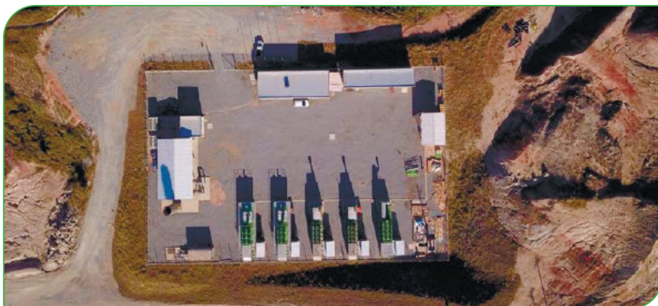
Unidade de tratamento de chorume e usina de biogás da Macaúbas
