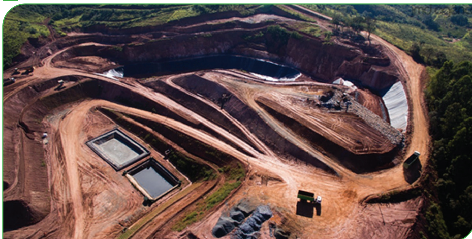
Aterro Classe II com argila compactada e Geocomposto Drenante
