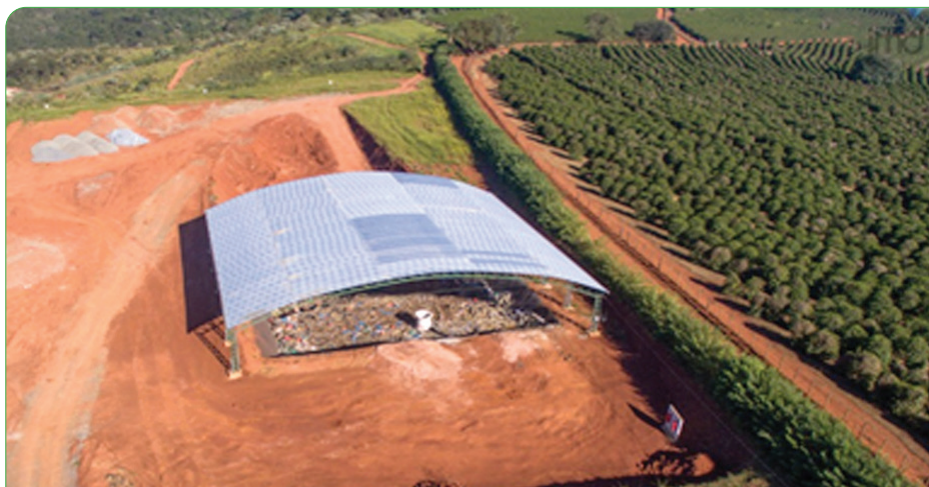
Aterro classe I com cobertura metálica e sistema de impermeabilização
